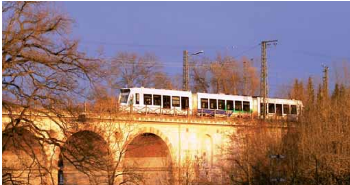
Kassel kombitrikk på Baunaviadukt Guntershausen jernbanebru, foto: Nordhessischer VerkehrsVerbund
